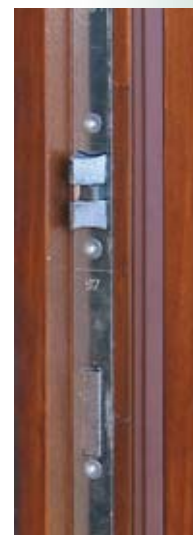
DETAIL POLODRÁŽKY DVEŘÍ* / DETAIL OF DOOR HALF-GROOVE
