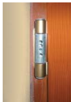
DETAIL ZÁVĚSU 3D (BEZ KRYTKY)* DETAIL OF 3D HINGE (WITHOUT COVER)
